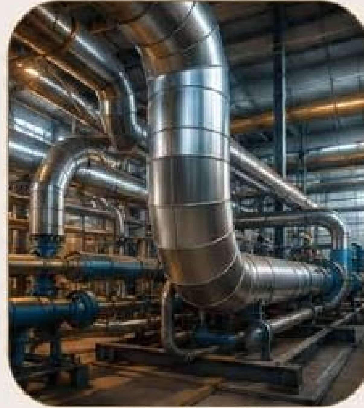
الأعمال الكهروميكانيكية Electromechanical Works
